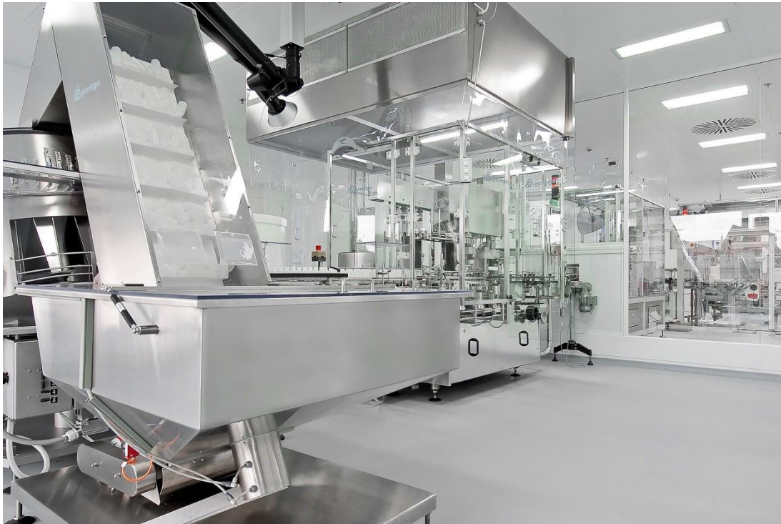
Abbildung 1 Intelligente Anlagenvernetzung verbindet die Produktionsprozesse mit dem Gebäude.
