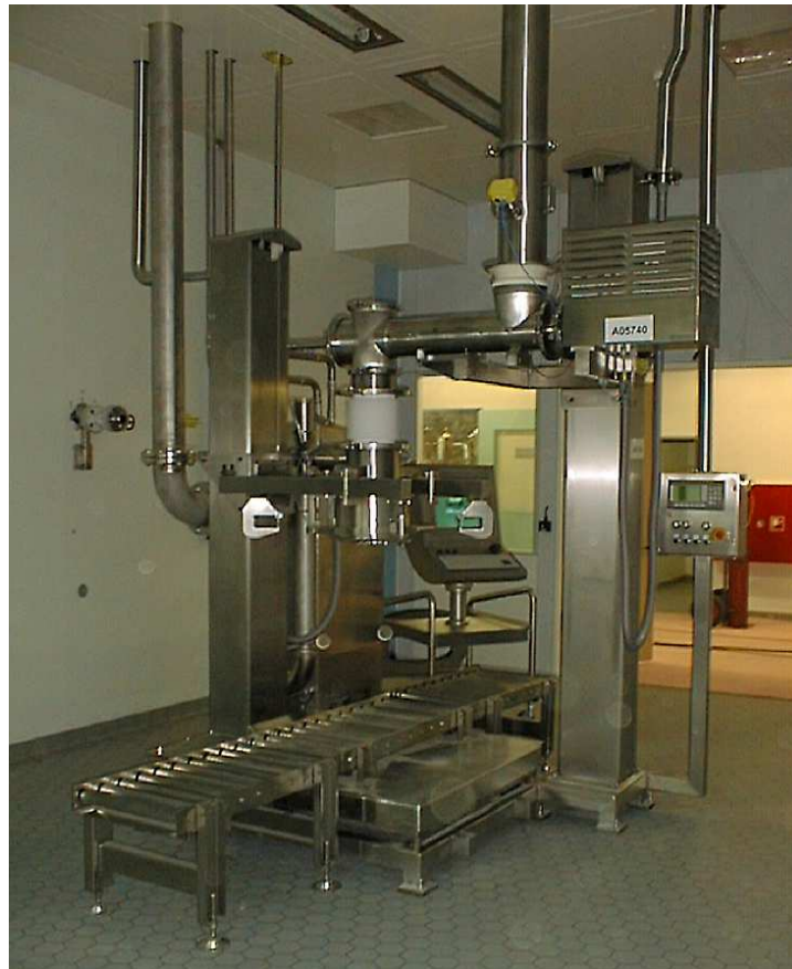
Abbildung 1 Beispiel einer hygienegerecht konstruierten Feststoff-Anlage
