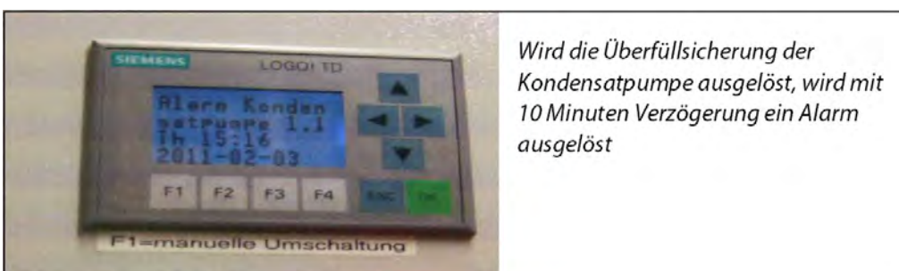
Abbildung 5-22 Simulation einer Störung an der Kondensatpumpe
