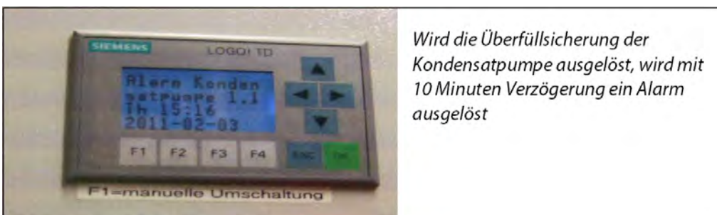
Abbildung 5-22 Simulation einer St rung an der Kondensatpumpe
